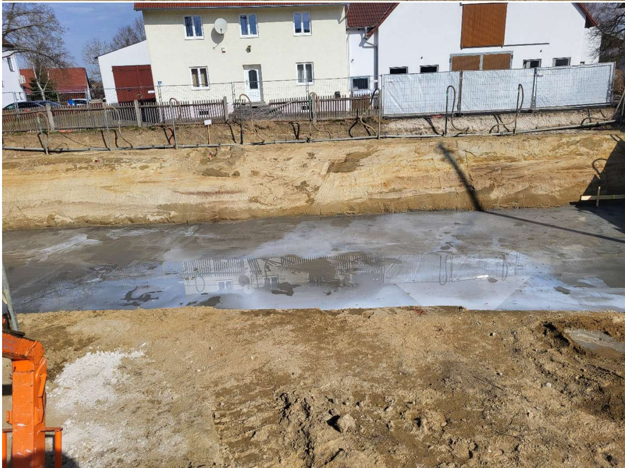
Sauberkeitsschicht, Dämmplatten und Beton-Bodenplatte für 5-Spänner
