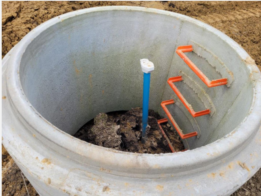
Foto 5 Grundwassermessstelle GMS-03 (im zentralen Bereich des Baufelds) wurde während der Bauarbeiten mit einem Betonring gesichert. Foto vom 18.12.2024.
