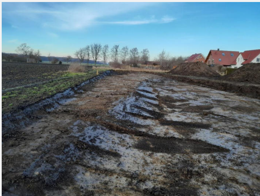
Foto 6 Freilegen der Auffüllung der ehemaligen Bahntrasse durch Abheben des Oberbodens. Foto vom 03.02.2025.
