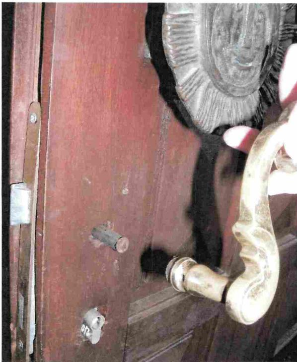
**Bild 5: überalterter EG-Hauseingangstür mit Einbruchs-Schäden**
