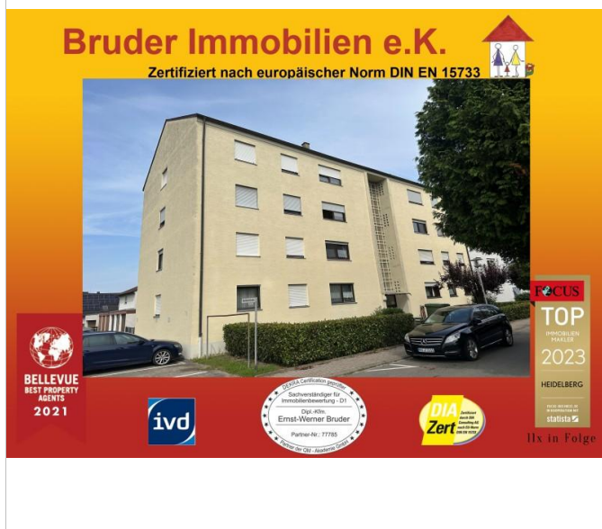
Fassade in Sackgasse
